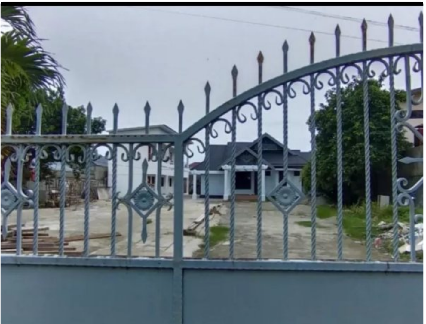
Mess Pemda Morowali di jln Garuda Palu
