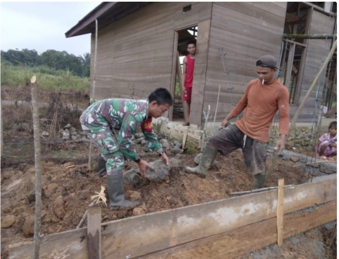
Serda Nonong bantu kerja pondasi rumah warga
