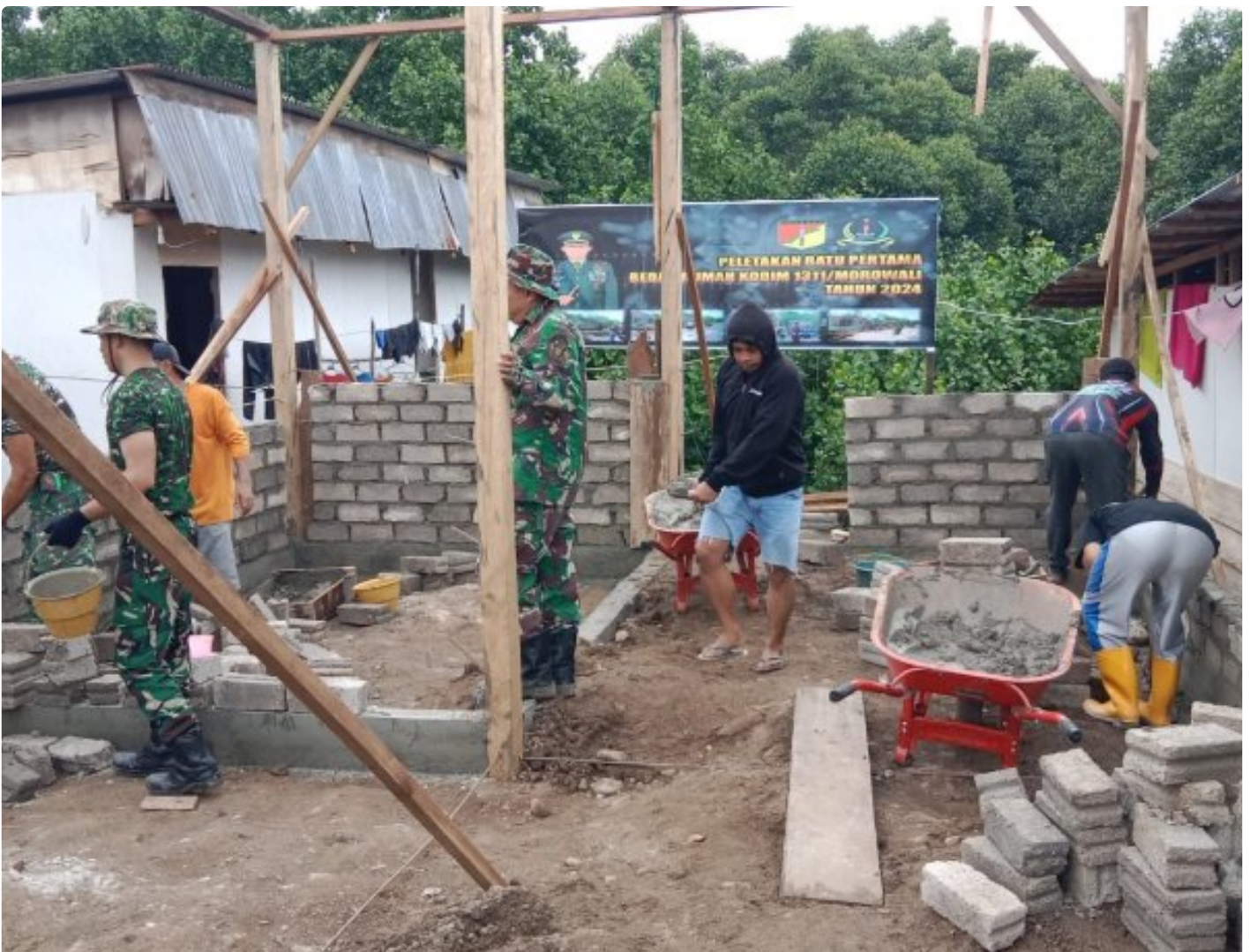
Tampak pengerjaan bedah rumah tahap pemasangan Batako
