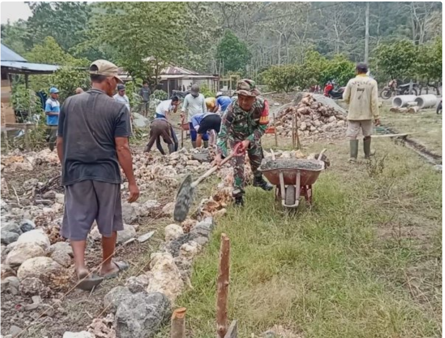
Gotong royong bangun pondasi rumah warga
